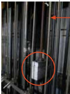
Les fils permettant la manipulation des perches se trouvent sur le côté de la scène. Les cintriers placent des charges équivalentes au poids du décor et de la perche à laquelle il est suspendu. Les charges blanches sont permanentes et correspondent au poids d'une perche, c'est-à-dire environ 60 kg.
